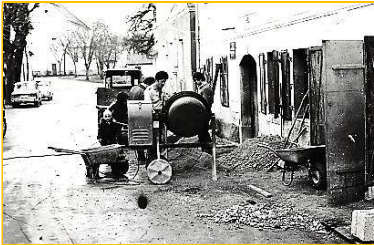
Slika: gradbena dela pri obnovi šole.
